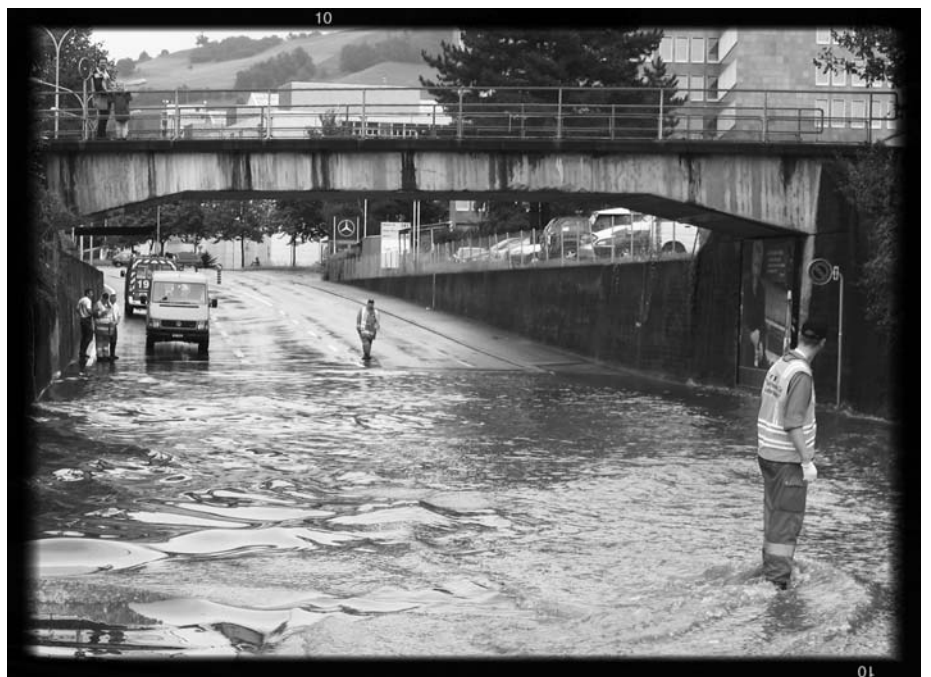
Die General-Guisan-Strasse in Zug unter Wasser.
