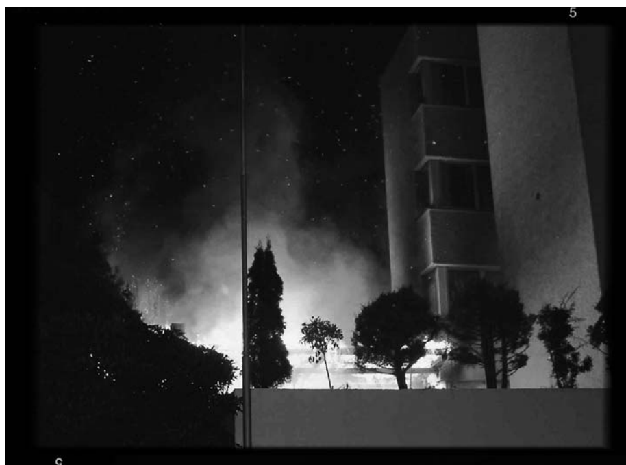
Pergolabrand an der Zuger Weidstrasse.
