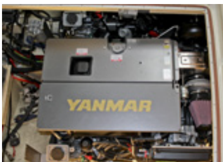
Motoren und Nebenaggregate sind montiert
