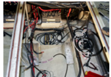
Der Motorraum wird für die Aufnahme der neuen Maschinen vorbereitet
