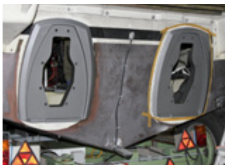
Das Heck wird für die Montage der neuen Antriebe angepasst
